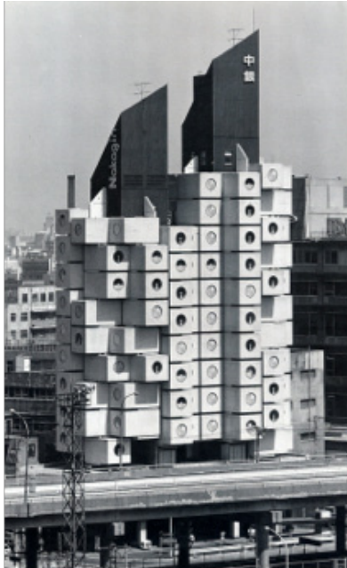
Fig.1 Immeuble Nagakin, 1972, K.Kurokawa
