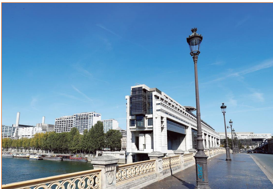
Bercy – Le bâtiment Colbert du Ministère de l'Économie et des Finances et du Ministère de l'Action et des Comptes publics, des architectes MM. Paul CHEMETOV et Borja HUIDOBRO.
