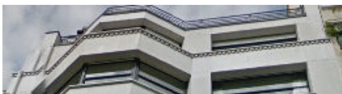
Figure 94 : Michel Roux-Spitz, 14 rue Guynemer 6 e , 1927, Innovation tempérée. Un liseré de denticules orne les balcons du 6 ème étage de l'immeuble 384 . L'architecte abandonnera cet élément pour tous les autres immeubles de sa série blanche.
