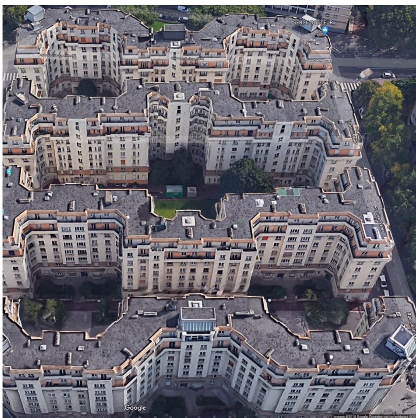
Figure 275 : Vue d'ensemble de l'opération réalisée, cliché GM.
