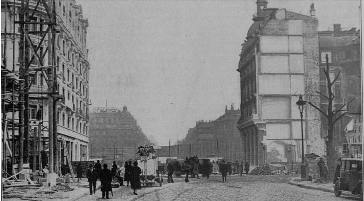
Figure 241 : La percée du bd Haussmann vers le carrefour Richelieu Drouot, cliché Chevojon, in la Construction moderne , n° 33, 16 mai 1926 p. 385.
