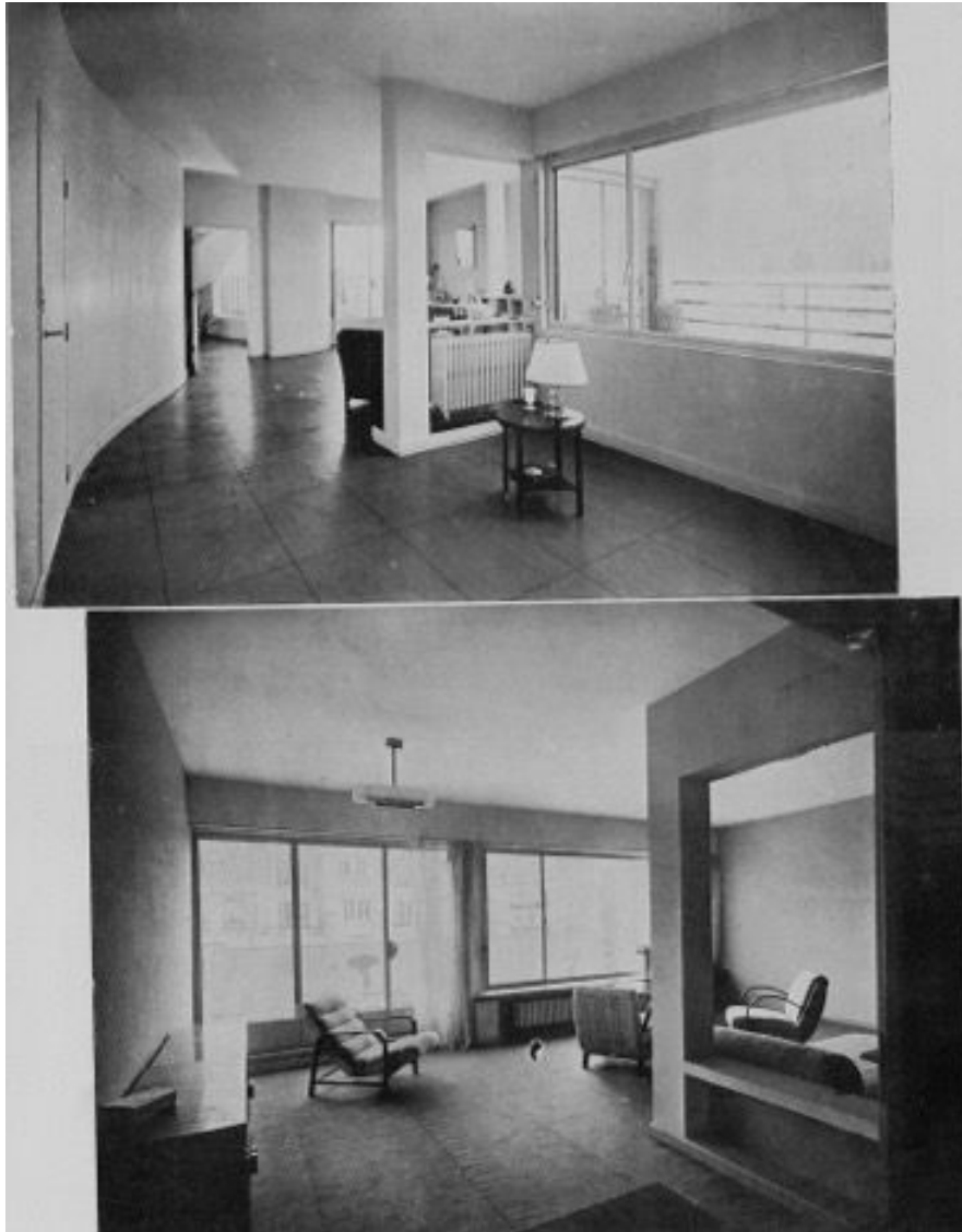
Figure 69 : Jean Ginsberg et François Heep : 42 bis av de Versailles 16è, 1935, in La Construction Moderne , 28 avril 1935, p. 655, cliché Salaün.
