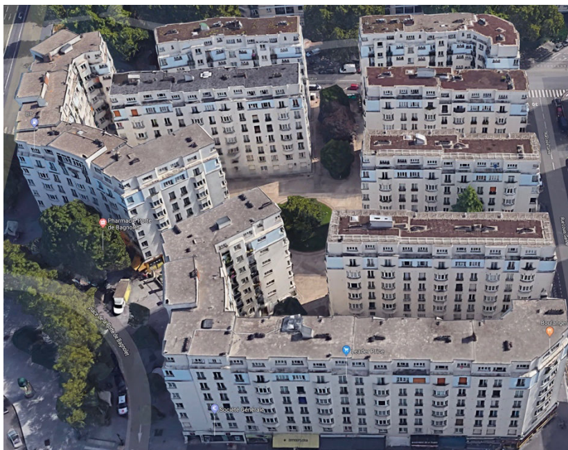
Figure 274 : Vue d'ensemble de l'opération réalisée, cliché GM.
