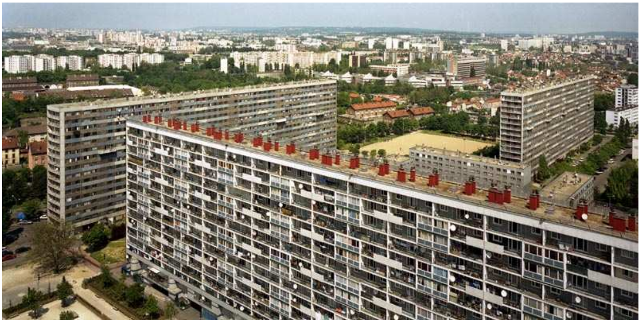
Cité des 4000 à La Courneuve
