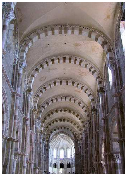
Nef et voûte de Vézelay
